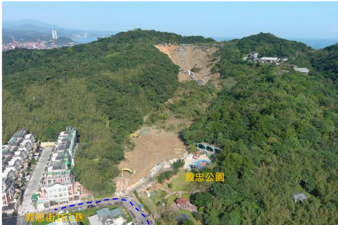
圖 3、基隆槓子寮崩塌區域 2022 年 2 月 28 日空拍影像 (資料來源：災防科技中心)
