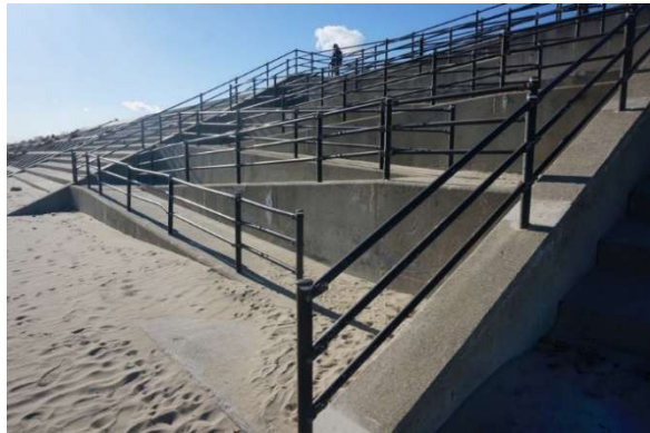
(d)海岸堤防(靠海側)及無障礙坡道
