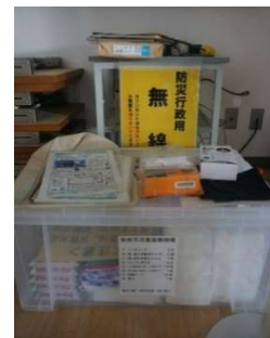
(d) 防災無線通訊設備
