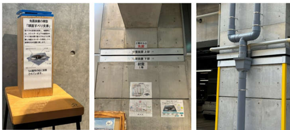
圖 2.4.5、建物梁柱及水管的抗震設計
