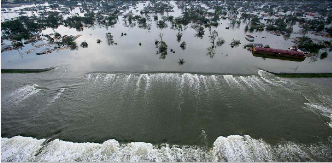
圖四 洪水由破堤處湧入（摘自 Newsweek 網站）
