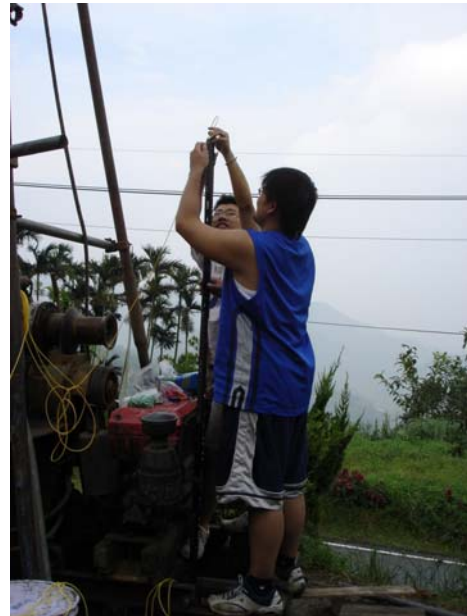
圖 4.1、NCTU-01 節理式光纖光柵偏斜儀裝設概況圖
